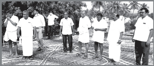
சி.எஸ். கட்டிட இரண்டாவது தள பணிகள்
